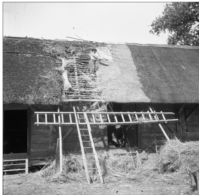
Slika 1: Krovcec Jože Skubic iz Prekope pri prekrivanju strehe skednja v Malencah pri Kostanjevici (foto: Fanči Šarf, Slovenski etnografski muzej, 1. 8. 1956).
