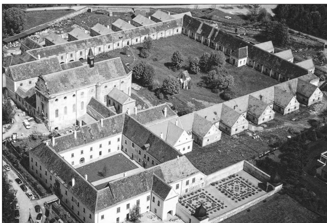
Pogled na informacijski in izobraževalni center za ohranjanje arhitekture v kartuziji Mauerbach (©Bundesdenkmalamt, 16. 5. 1999).
