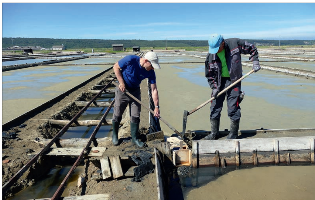
Slika 8: Primož Pipan in solinar Matjaž Lužnik med menjavo solinske zapornice imenovane kolo.
