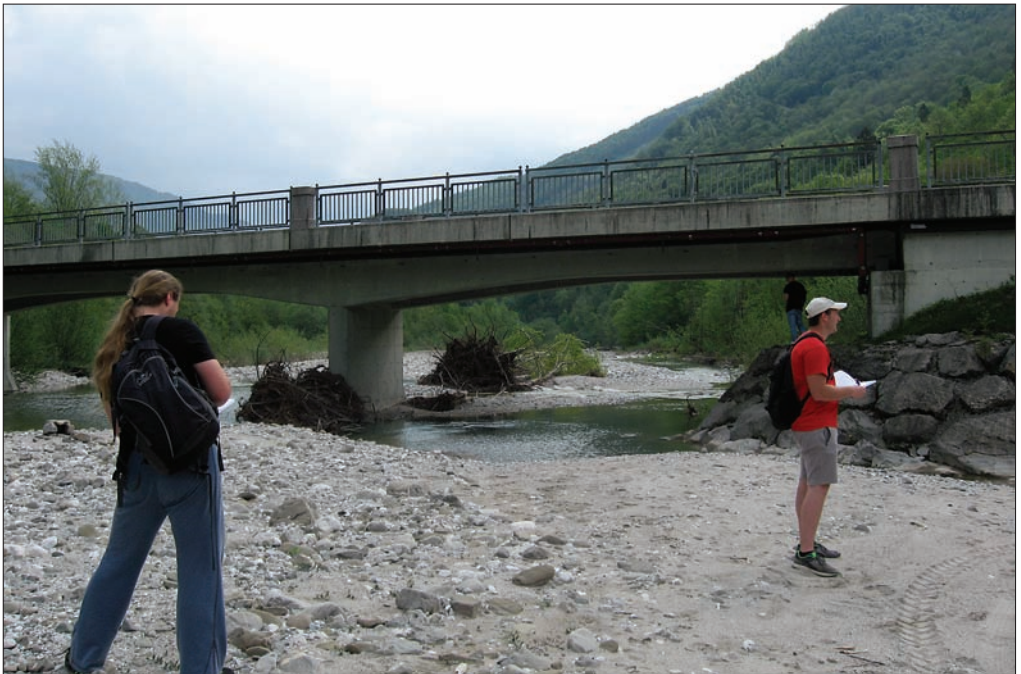
Slika 6: Most čez Nadižo pri Podbeli z betonskimi podporniki in utrjeno brežino s skalometom.
