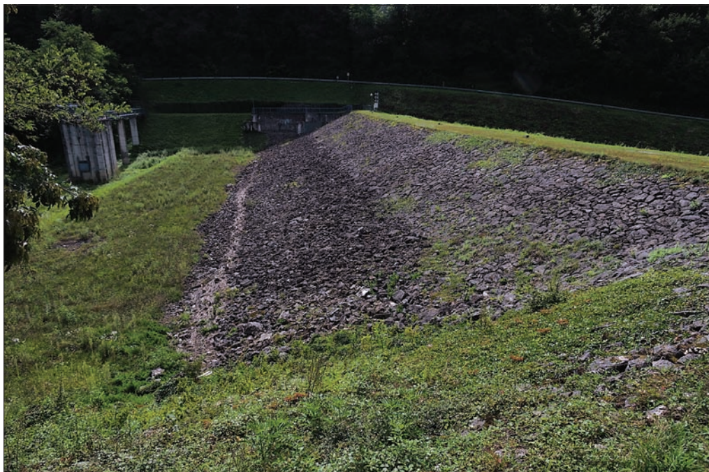
Slika 2: Pregrada Vonarje na reki Sotli na slovensko-hrvaški meji. Zajezitev je bila narejena kot večnamenska: za poplavno varnost, preskrbo s pitno vodo, namakanje kmetijskih zemljišč, ribolov in turistično-rekreacijske dejavnosti. Zaradi slabe kakovosti vode je bila edina dovoljena raba preprečevanje poplav (Hrvatina, Komac in Zorn 2020).
