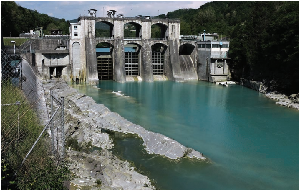
Slika 2: Vodni potencial reke Soče je pomemben za pridobivanje hidroenergije – pregrada Ajba, zgrajena za potrebe HE Plave, ki je začela obratovati leta 1940.
