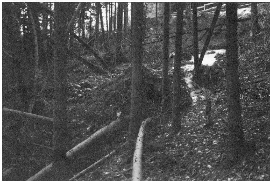
Slika 3. Plaz v Zabrezniku pod makadamsko cesto je odnesel več dreves.
