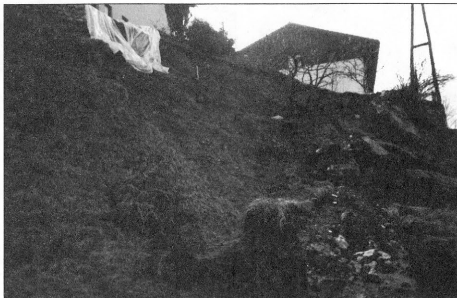
Slika 1. Plaz na izlakah ogroža stanovanjsko hišo, saj je odlomni rob oddaljen od nje le en meter.
