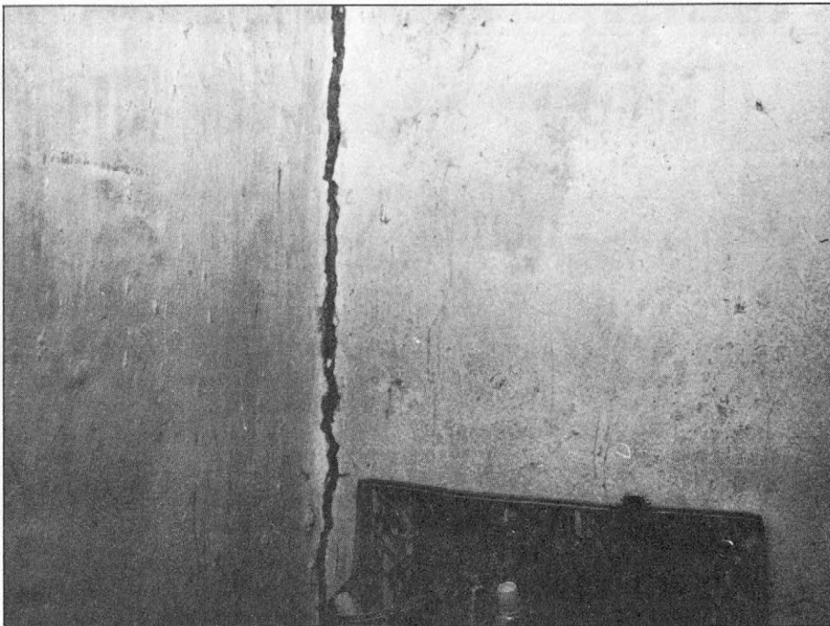
Slika 9. Globoke razpoke, širine več kot centimeter, na vogalnem stiku nosilnih zidov v župnijskem uradu na Sv. Primožu. (Foto: M. Godec)
