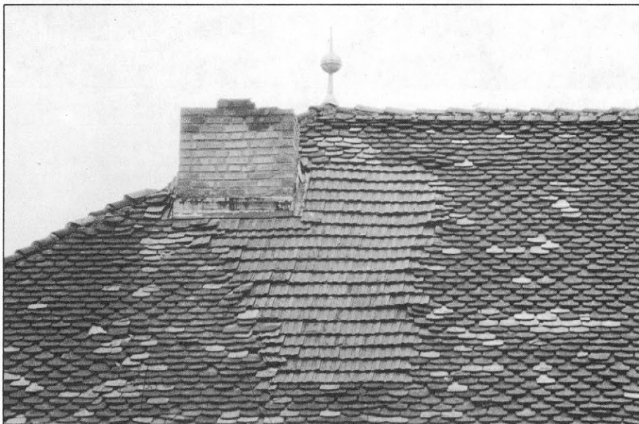
Slika 4. Odlomljeni dimnik na starem samostanu v Radljah ob Dravi (strešna opeka je že obnovljena). (Foto: M. Godec)
