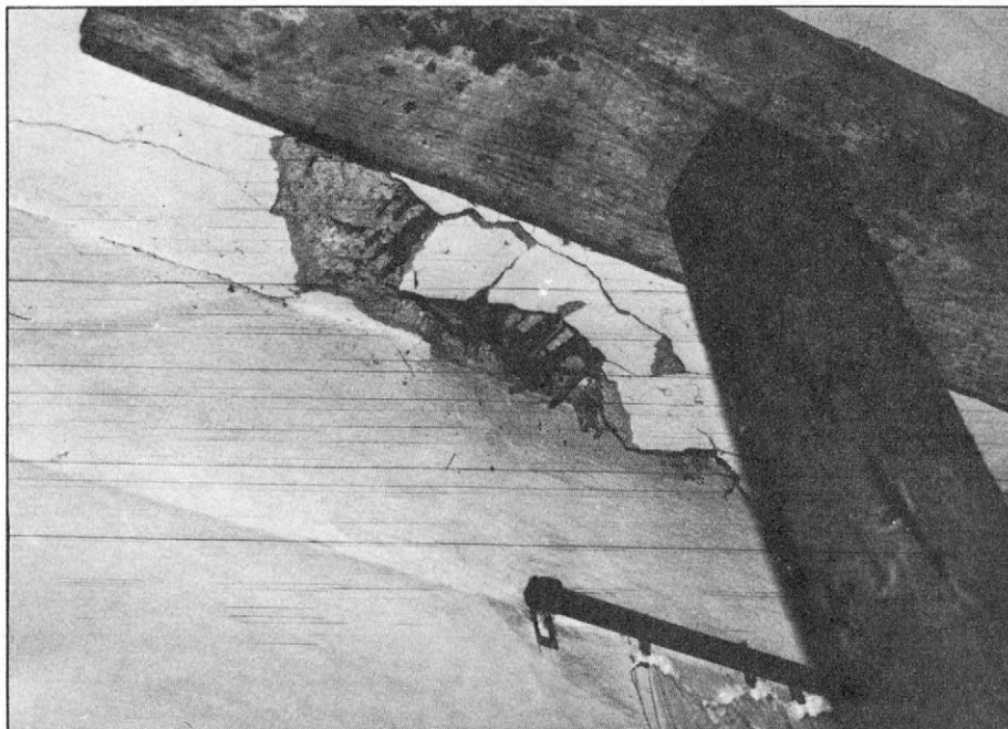
Slika 5. Popuščanje stropne konstrukcije zaradi napake pri opori. Stropniki ne nalegajo na nosilni zid. Pri potresu so delno izgubili podporo (Muta, Cesta 4. julija 4). (Foto: M. Godec)
