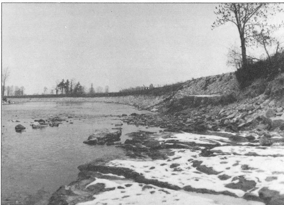
Slika 4. Struga Savinje pri Vrbju. Zgornji del levega brega z nasipom, ki ščiti vrbenski ribnik pred poplavo, so že obnovili, spodnji del pa še čaka popravila in zaščite. (Foto: M. Natek)
