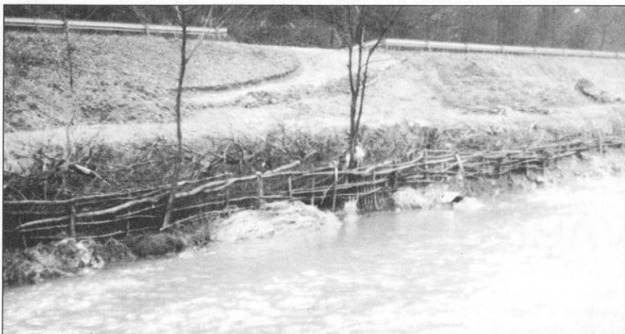
Slika 12. Desni breg Pake pod gorenjskim klancem. Kmetje s preprostimi in učinkovitimi posegi zavarujejo svojo zemljo pred izpodjedanjem in odnašanjem poplavnih voda. (Foto: M. Natek)
