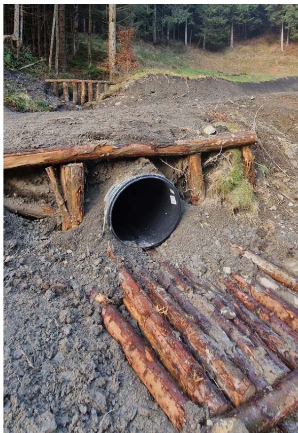
Slika 2: Manjši prebiralni objekt pred ustrezno dimenzioniranim cevničnim prepustom (foto: U. Vilhar)
