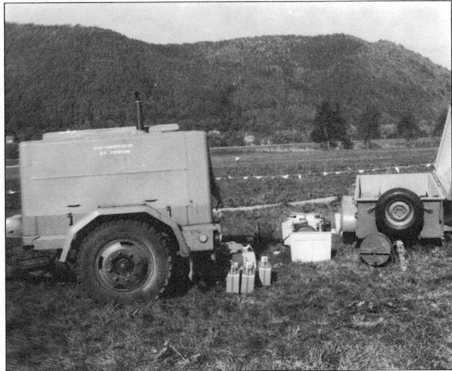
Slika 8. Agregat in tehnična rezerva.
