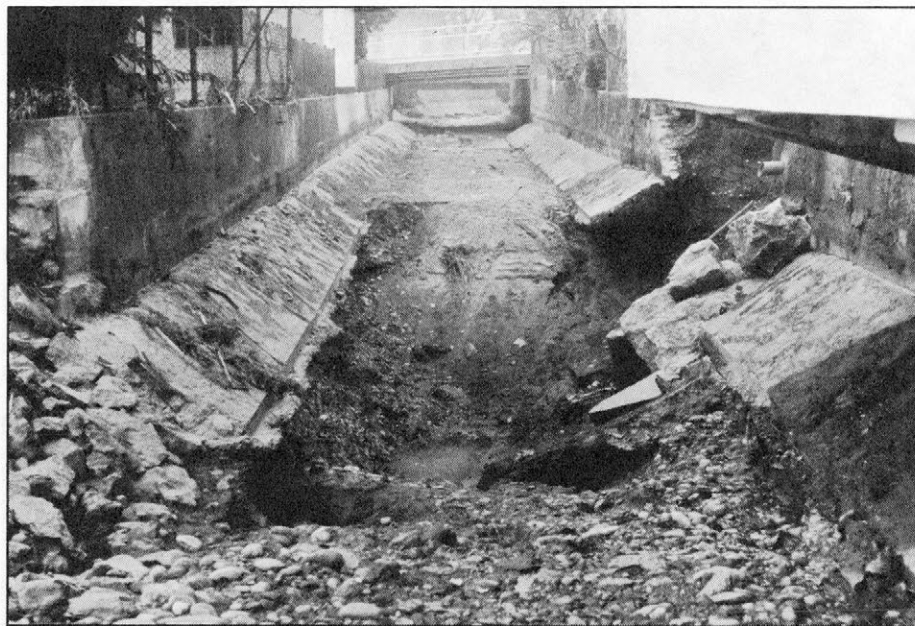
Slika 4. Dol — Mlinščica je spodjedla škarpo (foto Lipovšek)
