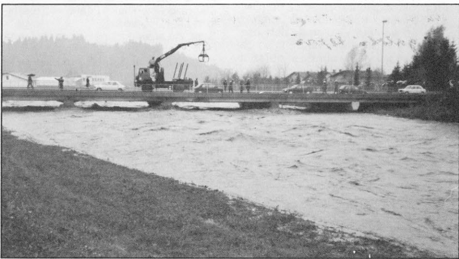
Slika 6. Domžale — most na glavni cesti. Sprotno odstranjevanje plavin.
