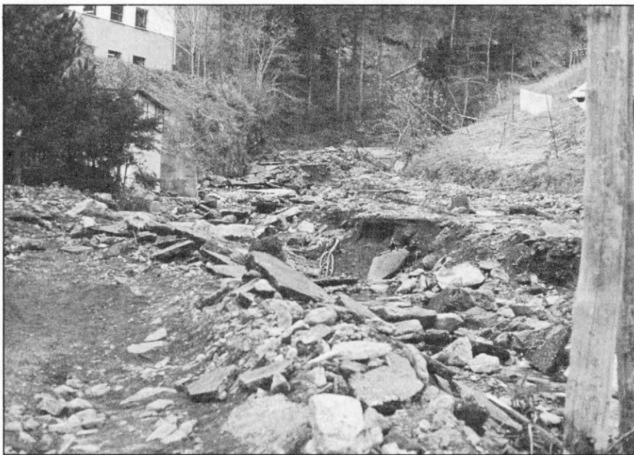
Slika 6. Razdejanje v spodnjem toku hudourniškega Lakovnika, malo nad izlivom v Savinjo.
