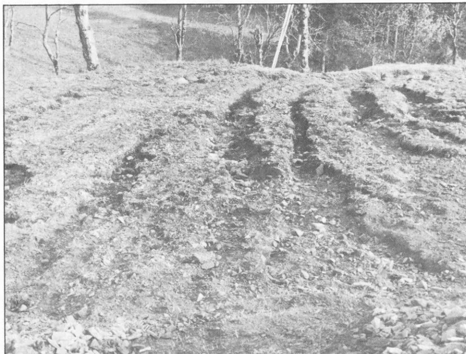
Slika 6. V območju maksimalnih padavin v povirju Drete je bila erozijska dejavnost še posebno izrazita. Voda se je na nagnjenih pobočjih hitro zbrala in formirala manjše vodotoke, ki so izkopalili številne erozijske jarke. Ti so ponekod posejani tako na gosto, da je zemljišče za nadaljnjo kmetijsko izrabo praktično neuporabno. Posnetek je iz Mačkinega kota pod Lepenatko (foto: Drago Kladnik).
