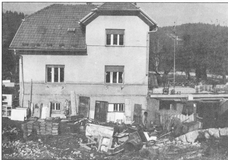
Slika 4. Narasla Savinja je močno prizadela nekatere stanovanjske objekte, ki jih niso obvarovali niti že v preteklosti zgrajeni protipoplavni nasipi. Ti so bili tokrat prenizki, nekatere pa je podivjana reka predrila. Na stanovanjski hiši v Prihovi se lepo vidijo sledovi, ki kažejo, do kakšne višine je segla voda v času poplavnega maksimuma (foto: Drago Kladnik).
