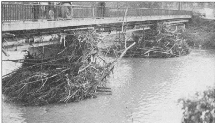
Slika 5. Še teden dni po povodnji so bili nosilci šoškega mosta (med Šempetrom in Šoškami) zatrpani z drevjem, grmovjem in vejvjem (Foto M. Natek).
