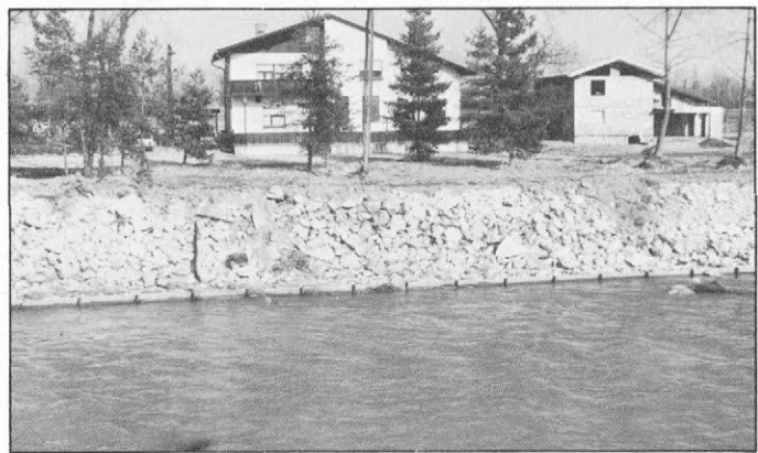
Slika 7. Gostišče Plevčak pri grobeljskem mostu v Latkovi vasi. Povodenj je odnesla levi varovalni nasip in preplavila gostišče ter polja vzdolž Savinje.
