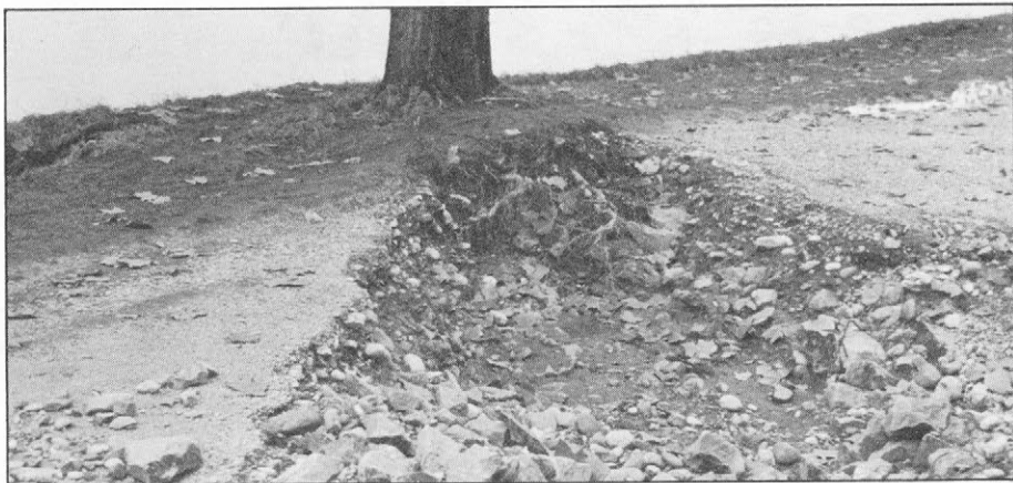
Slika 1. Sprehajališče na Savinjskem obrežju v Celju je povodenj razorala z globokimi erozijskimi brazdami (Foto M. Natek).
