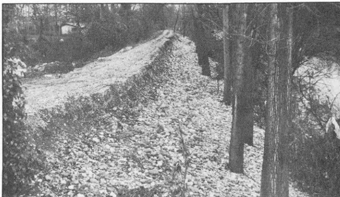
Slika 9. Desni breg Savinje med izlivom Kolje in šoškim mostom. Povodenj je izpodjedla in odnesla precejšen del nasipa, po katerem je speljan kolovoz do počitniških domov. Varovalni topolov nasad je preprečil še hujše razdejanje (Foto M. Natek).
