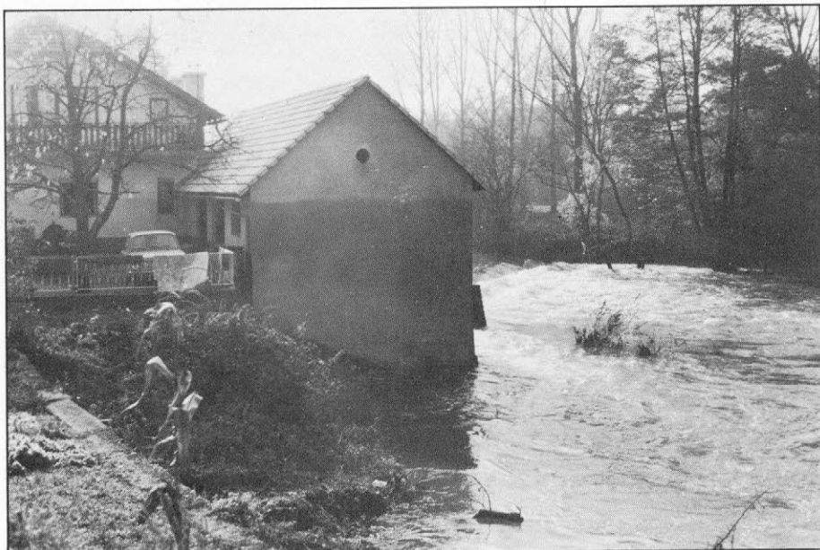
Slika 10. V garaže predelan opuščen mlin v Krški vasi pri Brežicah je zalila po Savi zajezena Krka vse do pod strehe, k njemu prislonjeno hišo (št. 14) pa do srede oken.
