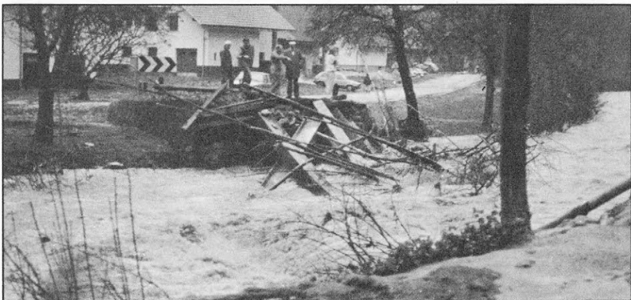
Slika 2. Voda odnesla most v Železnikih, zaprta cesta Železniki—Primorska, odrezane KS Davča, KS Sorica in del KS Železniki.
