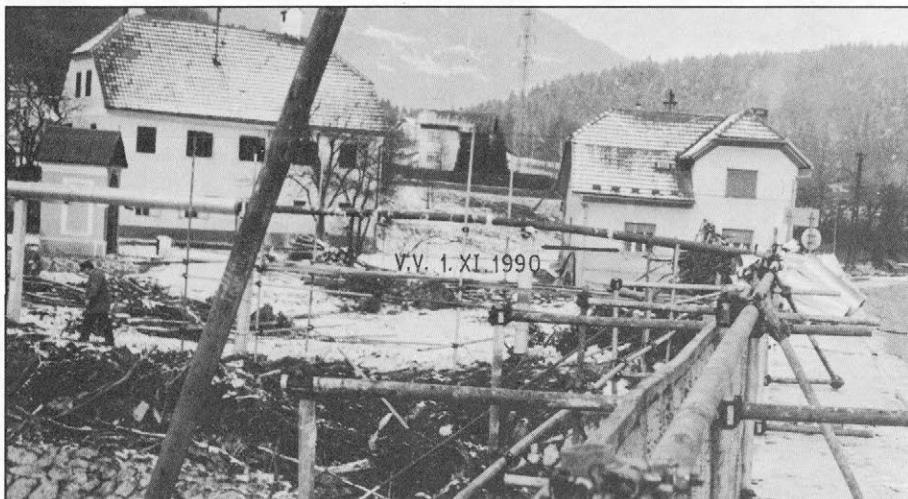
Slika 2. Po visoki vodi Savinje 1. novembra 1990 v Nazarjih. Most Nazarje—Gornji Grad je bil poškodovan zaradi zamašitve z odplavljenim materialom. Na hiši je vidna sled visoke vode. (Foto: M. Kolbezen)
