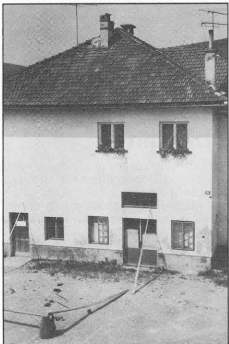
Slika 8. Pogled na odlomljeni dimnik na objektu v Vidmu 36c.
