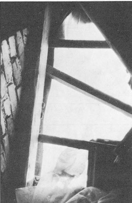
Slika 9. Poškodovana streha zaradi odlomljenega dimnika na objektu v Vidmu 36c.
