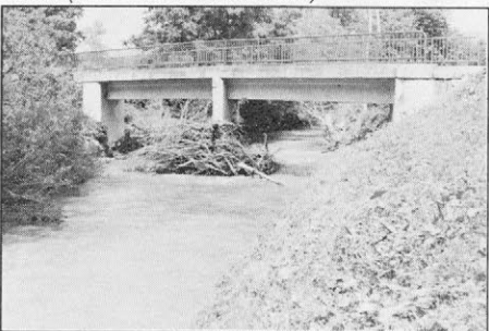
Slika 5. Zamašitev mostnega propusta prek Bistrice pri Bistrici ob Sotli, julija 1989. (Foto: Marko Kolbezen)
