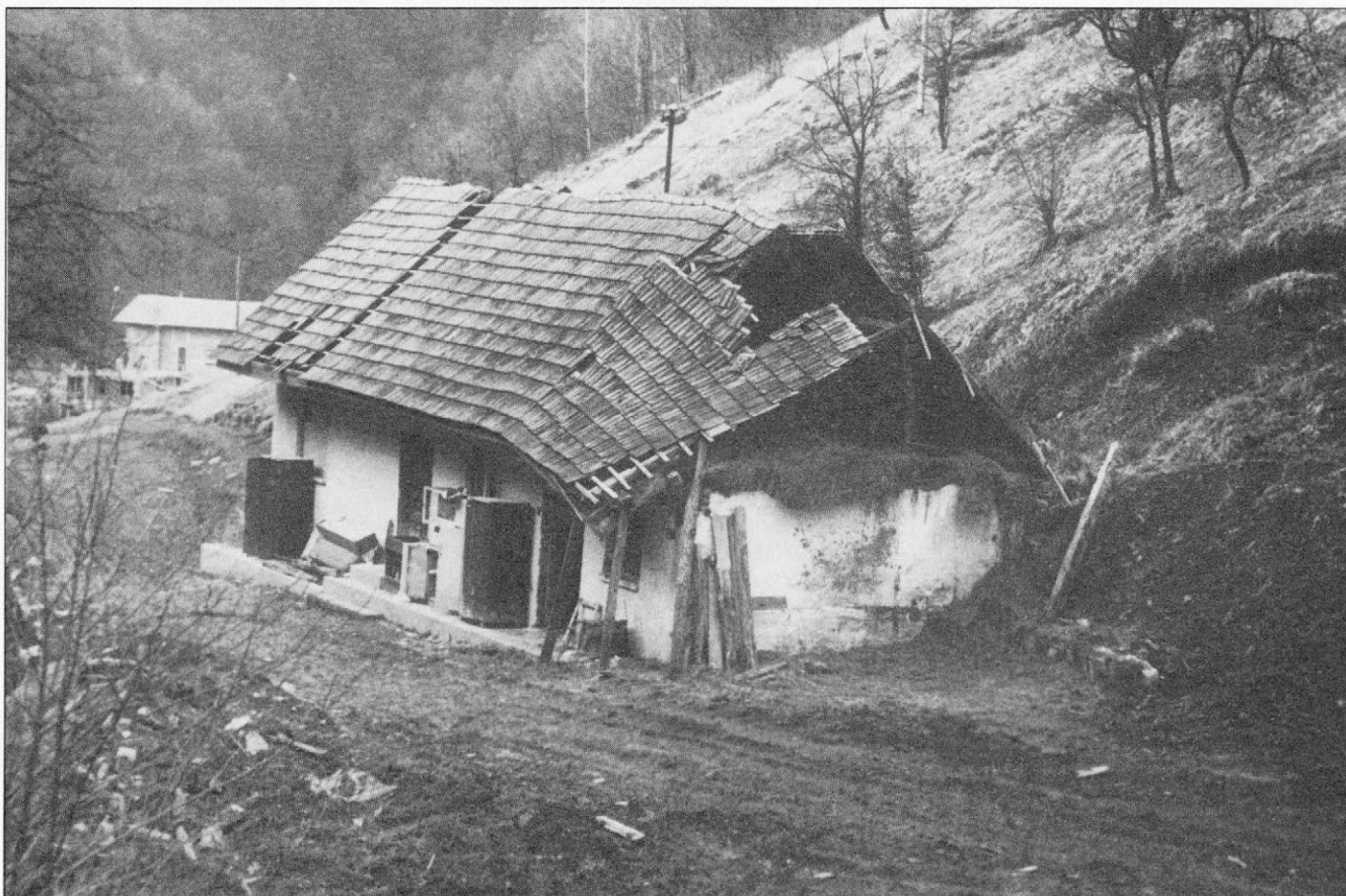
Slika 4. Z zemeljskim plazom zasuta stanovanjska hiša in porušeno gospodarsko poslopje v naselju Planjsko.
