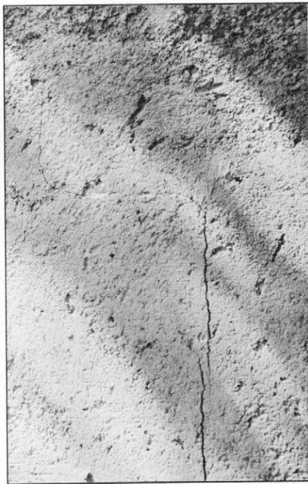
Slika 7. Manjše poškodbe so nastale v Klinji vasi, predvsem na starejših, slabo zgrajenih objektih. Na slikah a, b in c vidimo navpične razpoke fasadnega zidu. Zidovi so zgrajeni iz kamna, povezani so s slabo vezivno malto in so brez etažnih vezi.
