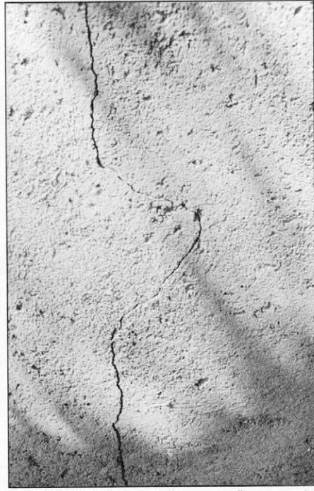
Slika 7. Manjše poškodbe so nastale v Klinji vasi, predvsem na starejših, slabo zgrajenih objektih. Na slikah a, b in c vidimo navpične razpoke fasadnega zidu. Zidovi so zgrajeni iz kamna, povezani so s slabo vezivno malto in so brez etažnih vezi.
