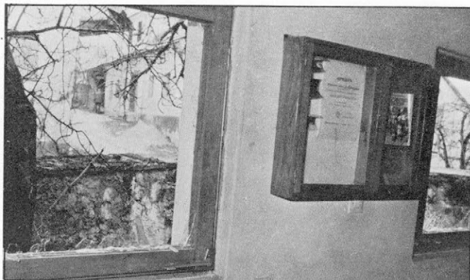
Slika 13. Razbita okenska stekla v sobi na zadnji strani cerkve. Podobno so se razbila stekla v večini sosednjih objektov (foto UNZ Ljubljana mesto).
