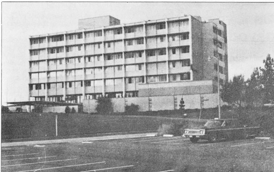
Slika 3. Bolnica Holly Cross po potresu v San Fernandu. (Vidne poškodbe na desni končni steni.)
