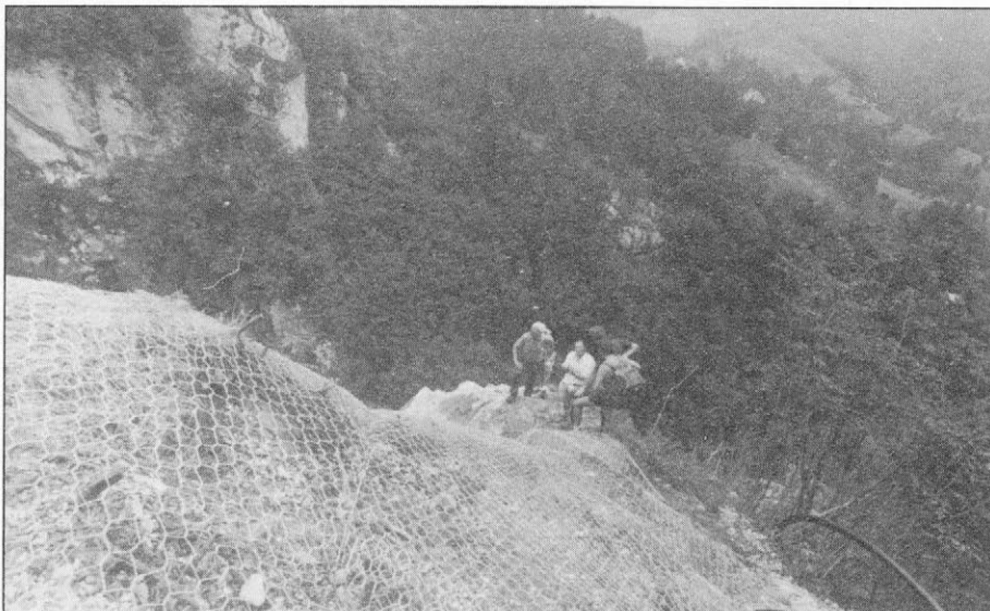
Slika 8. Tako izgleda majhen del sanirane brežine iz neposredne bližine. Delo je nadzoroval strokovnjak Zavoda za raziskavo materiala in konstrukcij iz Ljubljane. Dokumentacija MMI.
