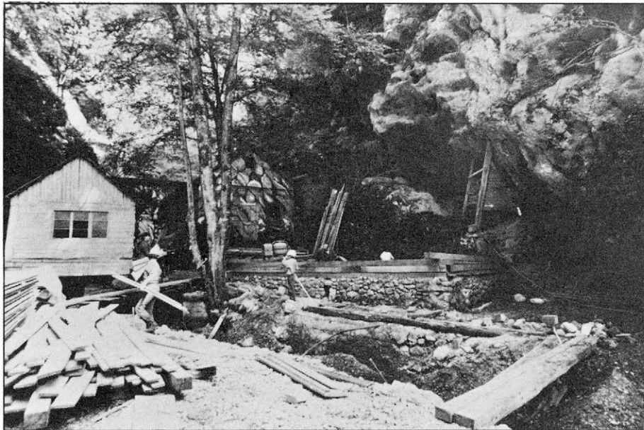
Slika 11. Ekipa Zidgrada in Mestnega muzeja Idrija je lahko pričela obnavljati objekte, ko je bil saniran kameninski podor nad bolnišnico in zagotovljena varnost. Dela so se začela avgusta 1989. Dokumentacija MMI.
