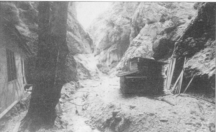
Slika 10. Pogled z istega mesta. Tokrat je soteska že očiščena in pripravljena za pričetek obnove poškodovanih in uničenih objektov.
