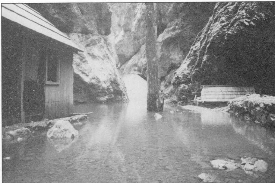
Slika 6. Po vsakem miniranju je obstajala nevarnost, da potok ob morebitnem hudem naliivu zalije bolnišnico. Delo je bilo temeljito načrtovano, zato je zalilo samo temelje prvih objektov. Dokumentacija GZL.
