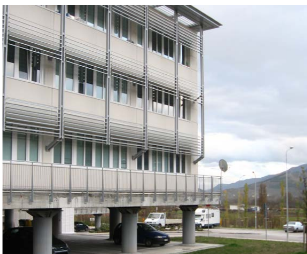
Slika 3: Primer večstanovanjske stavbe iz projekta C.A.S.E. (foto: J. Jeraj, november 2010)
