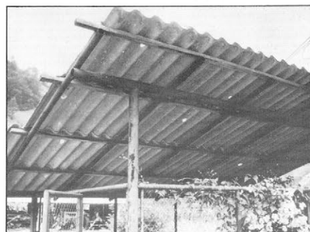
Zrna toče so preluknjala v Dolenji Trebuši salonitno streho.
