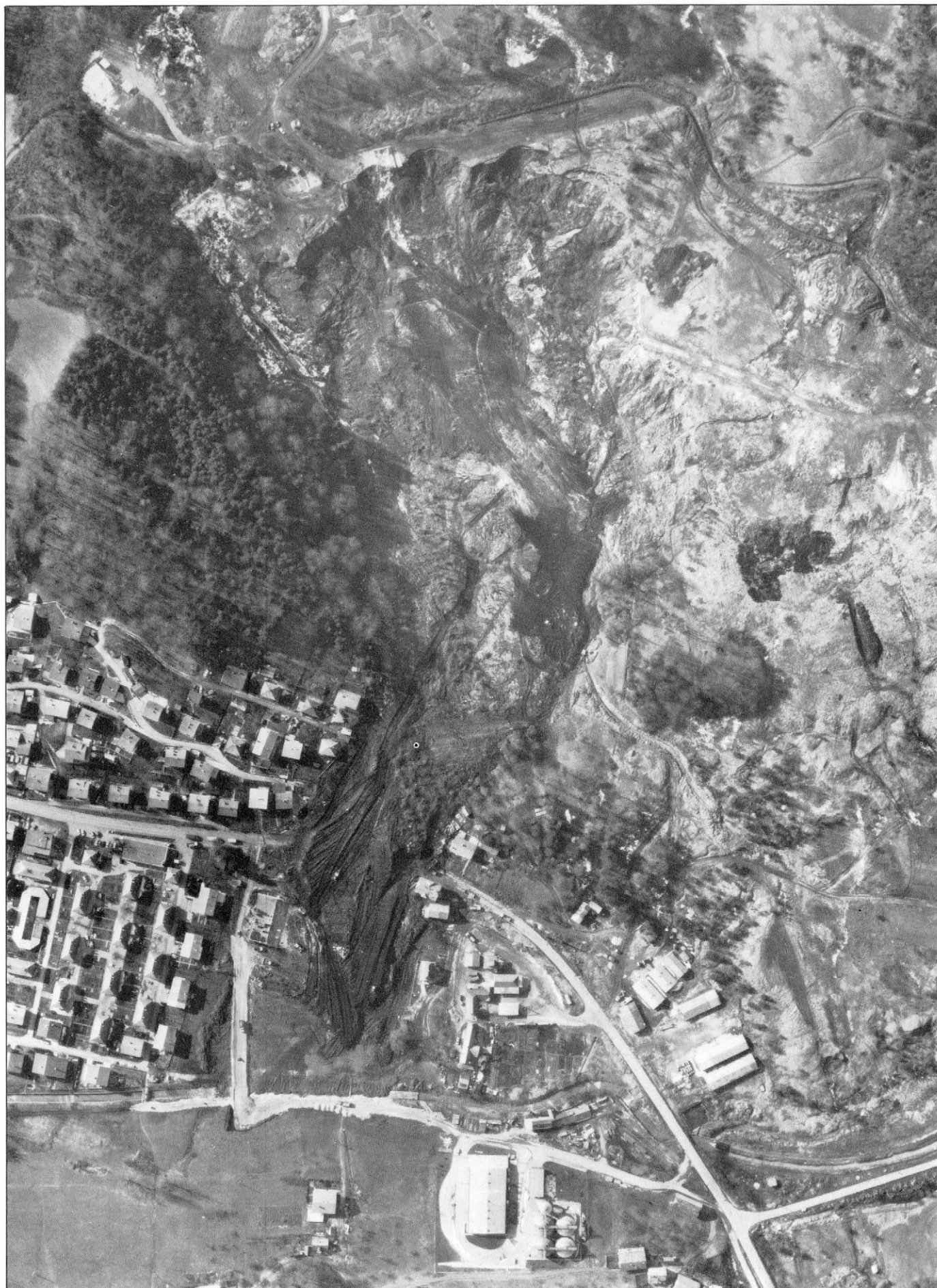
Po dogodku in pred dokončno sanacijo plazu (fotografija Geodetski zavod SRS).
