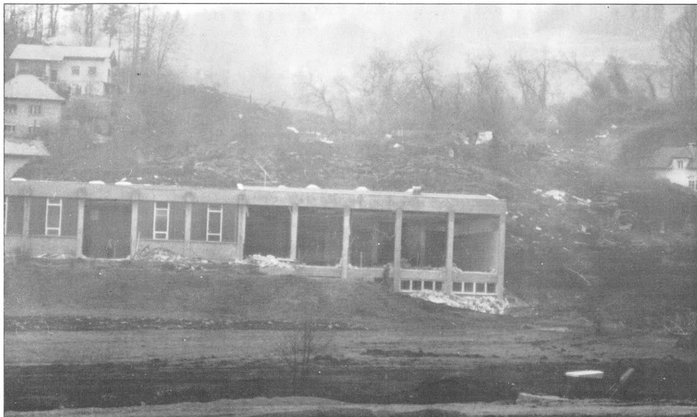
Izpraznjena hala tovarne Lisca tik pred porušitvijo.
