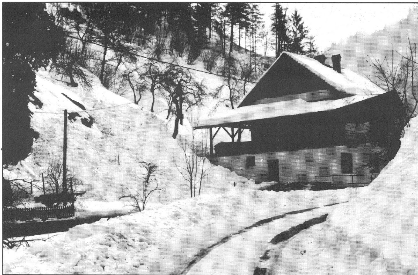
Slika 7. Plaz s pobočij Ahternika nad Hotovljo dobesedno rine v stanovanjsko hišo.
