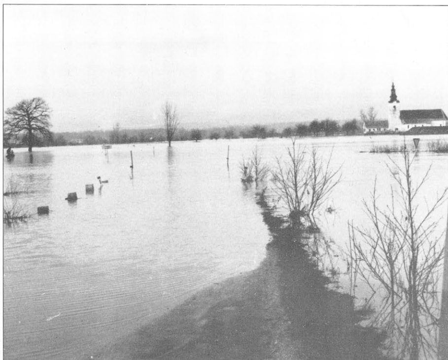
Slika 1. Poplavljenja cesta med Dobravo in Dramo 9. 12. 1976 (foto Milan Šifrer).
