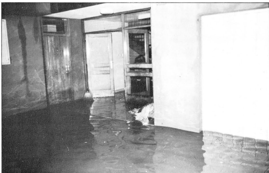
Slika 13. Poplavljen vhod v stanovanjski blok v ulici Marij Kogoj 1 d v Novi Gorici ob 1. uri 7. oktobra 1987, ko je voda že upadala (foto Daniel Rojšek).
