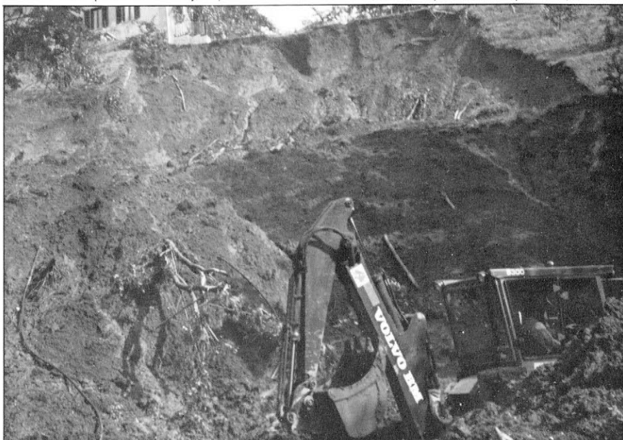
Slika 14. Zemeljski plaz v Markovem hribu v Rožni dolini pri Novi Gorici. Plaz je zasul cesto in ogrozil stanovanjsko hišo.
