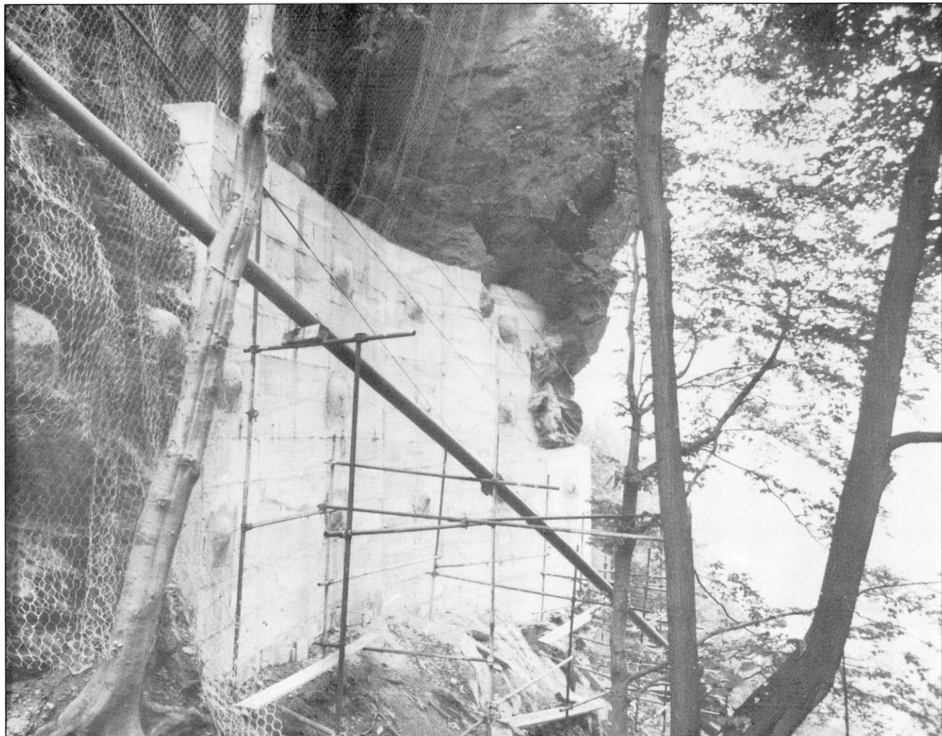
Slika 8. Zavarovanje previsne razpokane skalne stene z betonskim obložnim zidom in s trajnimi skalnimi sidri, 100 m nad železniško postajo Dravograd (Foto V. Štručl, nov. 1985)
