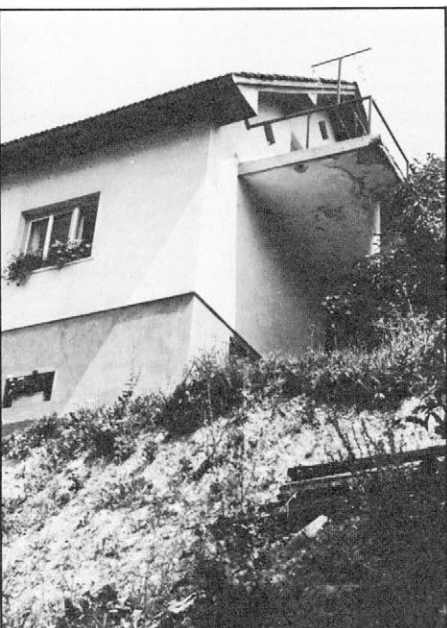
Slika 5. Pod Knezovim domom (Otiški vrh) je neurje 1986 ponovno podrlo škarko, ki bi naj zadržala rušenje strmega pobočja iz nesprijetih kvartarnih odkladnin. Ali ne bi bilo boljše, pred gradnjo več časa in sredstev nameniti vprašanju stabilnosti tal, kot pa zdaj razpravljati o usodi doma?
