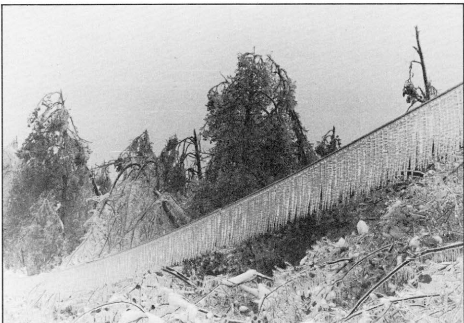
Slika 4. Z ledom obtežen vodnik — v ozadju polomljen gozd.
