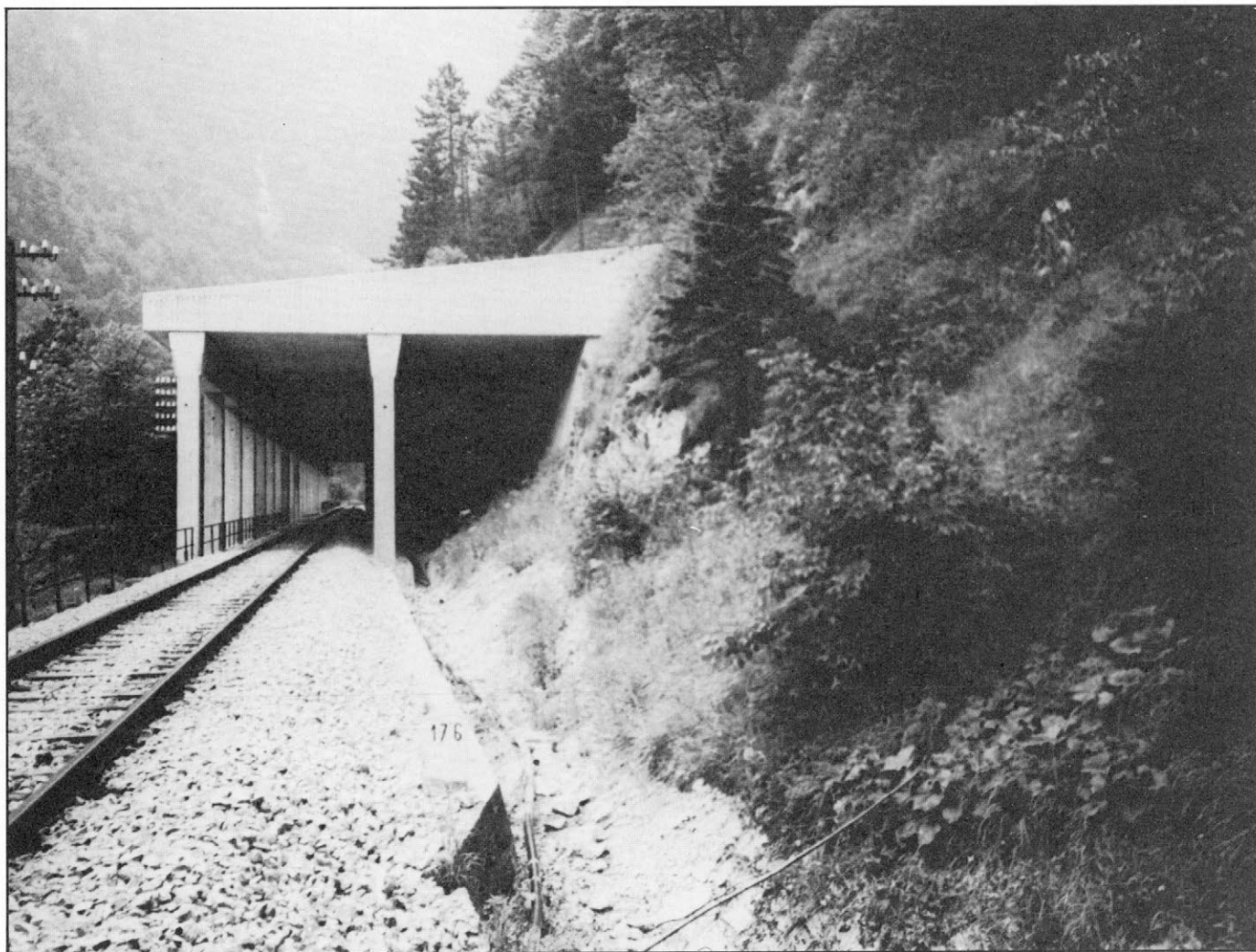
Slika 3: Protilavinska galerija v Soteski na železniški progi Jesenice—Bohinjska Bistrica.
