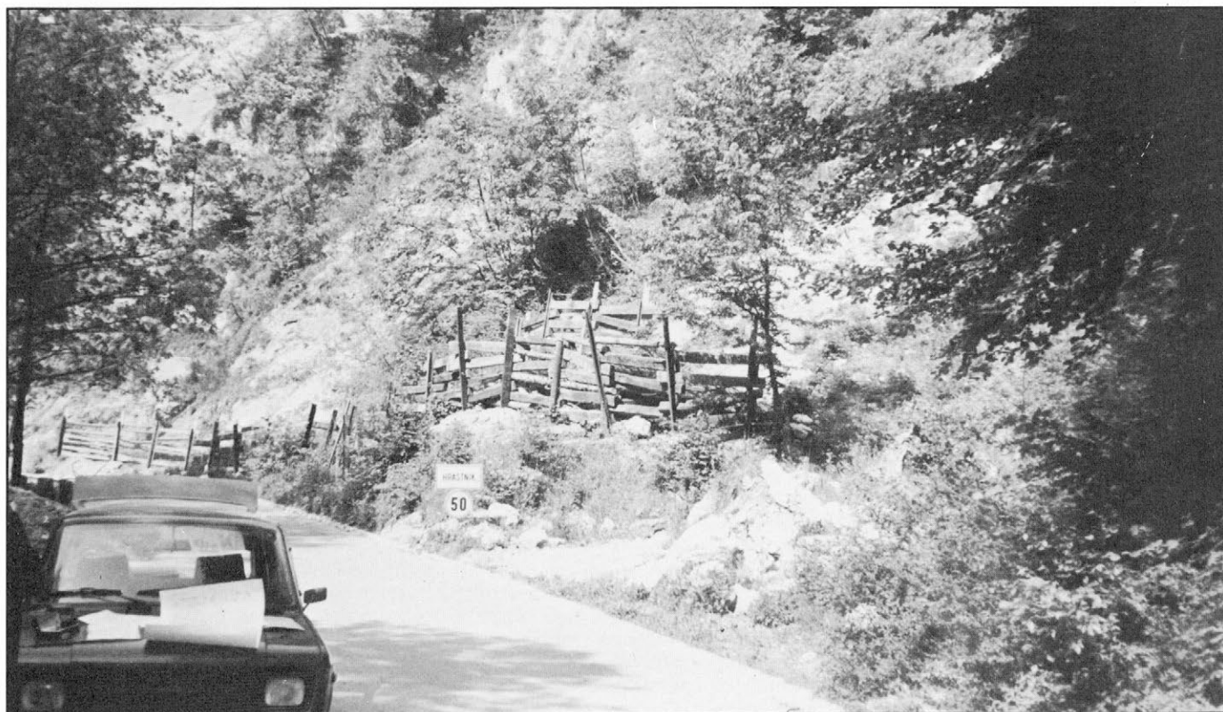
Slika 4: Pregrada iz starih železniških pragov, ki ščiti v Hrastniku cesto pred snežnim plazom.
