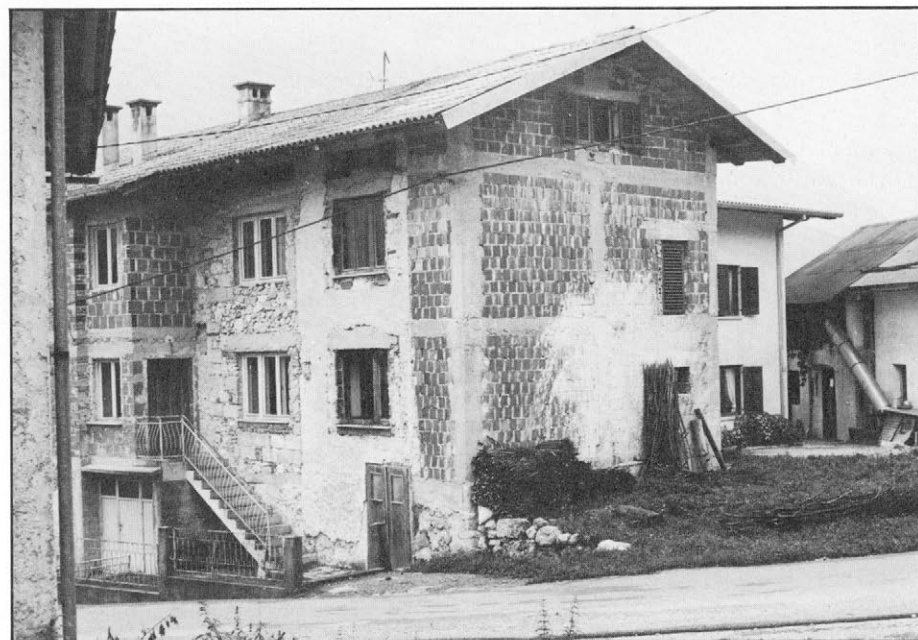
Slika 4. Pogled na isto mesto v letu 1984; namesto porušene hiše je zgrajen nov prizidek iz modularne opeke in s protipotresnimi vezmi.
