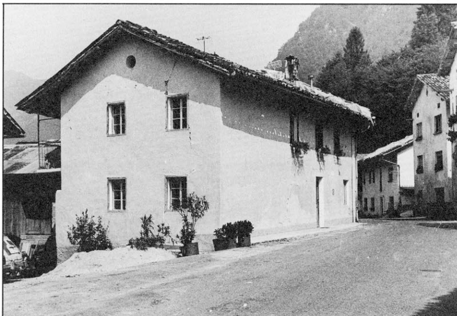
Slika 5. Pogled proti severnem koncu vasi Ladra (maja 1976): hiša v ospredju ter vmesna hiša na desni strani ceste sta bili kasneje porušeni.
