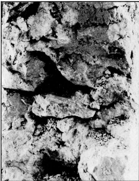
Slika 8. Preiskava nosilnosti starega kamnitega zidu na objektu. (Slikal M. Tomažević)
