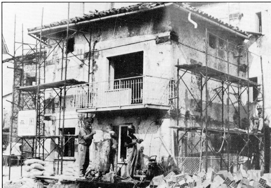
Slika 17. Bardó (Lusevera), Furlanija: ojačena hiša ni utrpela nobenih poškodb po septembrskih potresih leta 1976. (Slikal E. Vugrinec)
