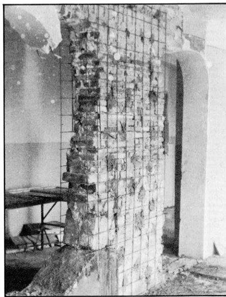
Slika 11. Tipična struktura starega kamnitega zidu. (Slika M. Tomažević)
