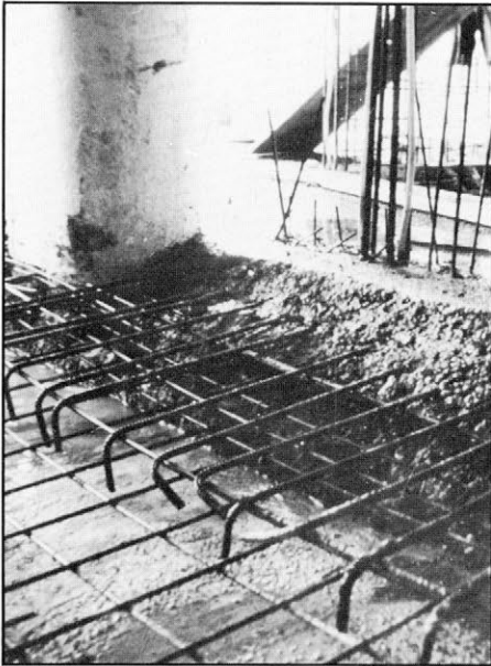
Slika 13. Oblaganje opečnega zidu z armiranim cementnim ometom. (Slikal M. Tomažević)
