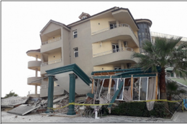
Slika 7: Hotel Vila Verde stoji v obalnem pasu Drača. Med novembrskim potresom sta se spodnji nadstropji hotela popolnoma sesedli, medtem ko so zgornja ostala skoraj nepoškodovana. (vir: Lekkas in drugi, 2019)
