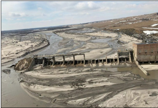
Slika 26: Poplave marca so v Nebraski, ZDA, uničile jez Spencer (vir: Urad guvernerja Nebraske, floodlist.com)
