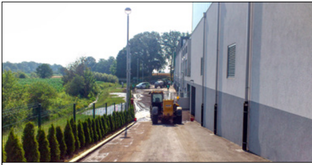
Slika 4: Nesreča izlitja digestata na bioplinski napravi (foto: S. Kolbl Repinc) Figure 4: Digestate spill at a biogas plant (Photo: S. Kolbl Repinc)
