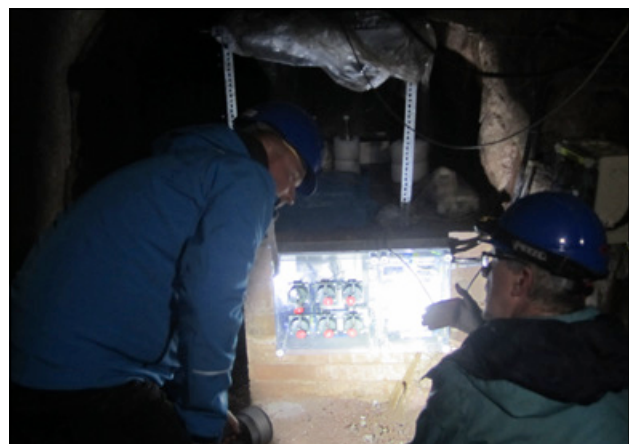
Slika 1: Zaradi velike vlažnosti v rovu so komunikacijski in električni priključki v posebnem na zunanji strani prozornem zaščitnem ohišju. (foto: I. Tasič)
