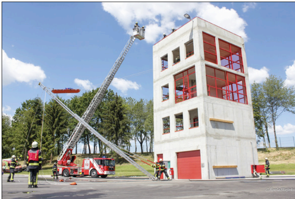
Slika 7: Uporaba stolpa za vaje – gašenje in reševanje iz višin (foto: Š. Stajnko, 2017)
