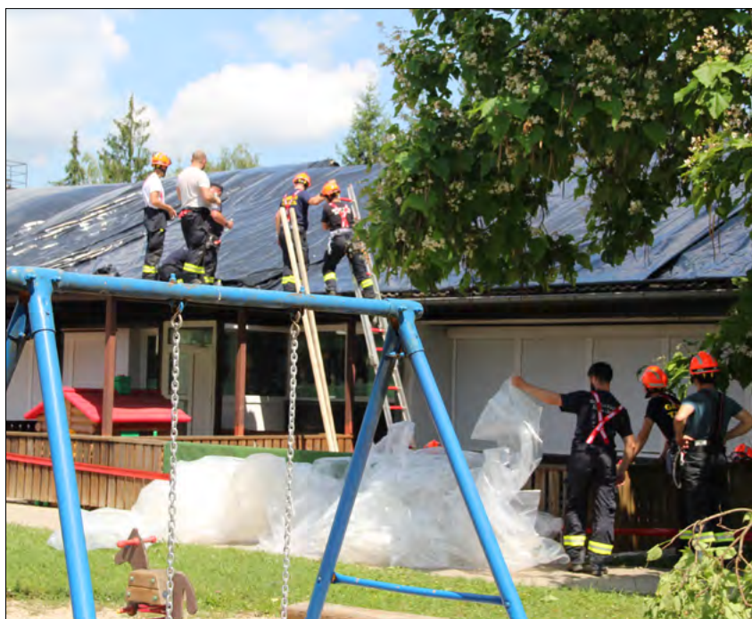
Slika 6: Izvajanje nujnih zaščitnih ukrepov na objektu Vrtec Otona Župančiča – enota Čardak, v soboto, 9. 6. 2018 (foto: arhiv GZ Črnomelj)
