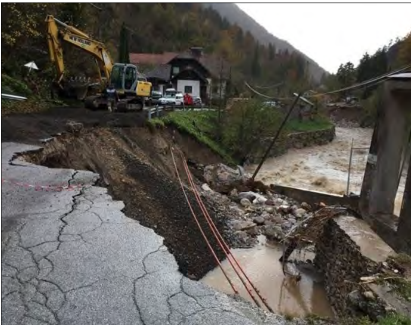
Slika 4: Škoda na zapornicah in prvi usad (foto: M. Cerkovnik, STA)
