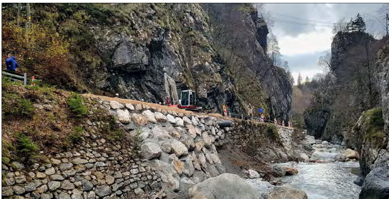
Slika 3: Hitra in učinkovita sanacija za tunelom na cesti proti Jelendolu (foto: Arhiv Občine Tržič)
