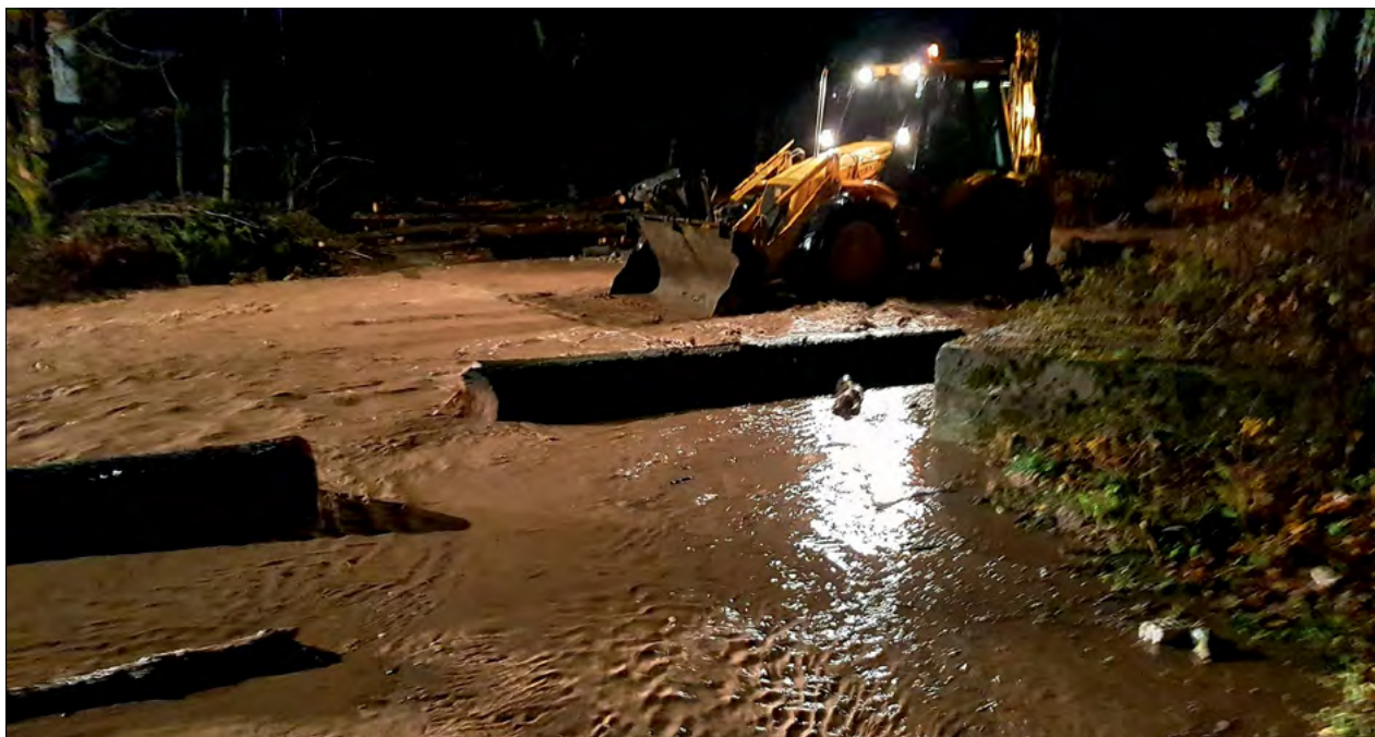
Slika 1: Lomščica je povsem poplavlila bližnjo cesto. (foto: Arhiv Občine Tržič)
