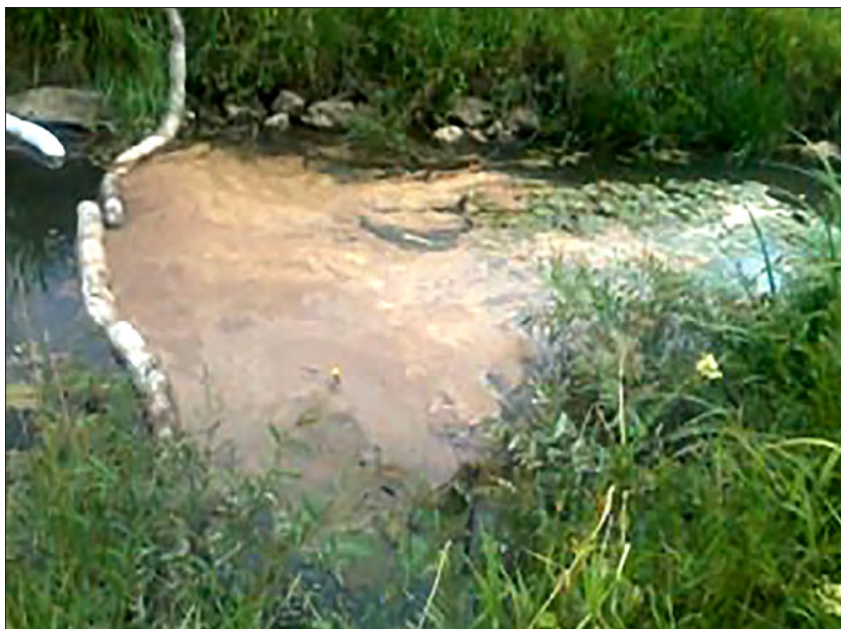
Slika 11: Vpojne pregrade – pivniki in gasilne pene na vodotoku Globetka, 9. junija 2017 (foto: B. Novak)
