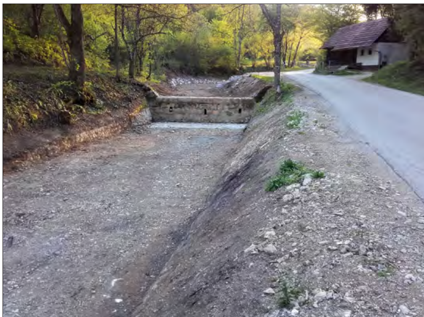
Slika 11: Utrjevanje struge Sušice in obnova manjše pregrade nad pritokom iz Levakove jame (foto: J. Tičar)
