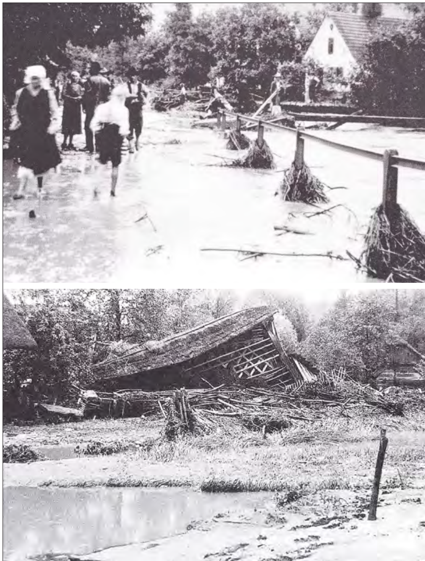
Slika 8: Osrednja cesta v Podbočju z razdejanimi mostovi (ygoraj) ter podrti kozolec Franca Colariča (spodaj) (Novak, 2000)
