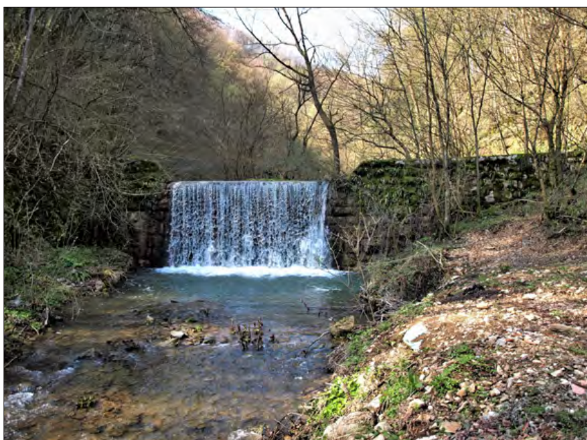
Slika 6: Večji zadrževalnik nad Dolom, ki učinkovito zaustavlja sedimente za pregrado. (foto: J. Tičar)
