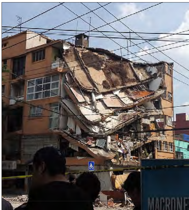
Slika 4: Poškodovana zgradba v Ciudad de México (vir: https://en.wikipedia.org/wiki/2017_Central_Mexico_earthquake )
